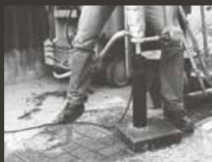
Diamantboren voor beton
